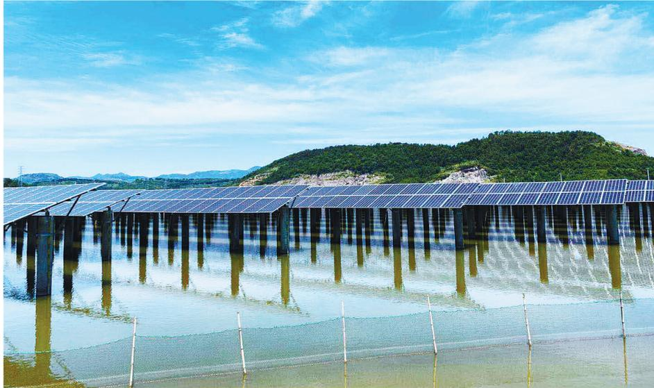
在宁海三门湾现代农业开发区,东方日升的“渔光互补”光伏发电项目实现水产养殖和光伏发电“一地两用”。
