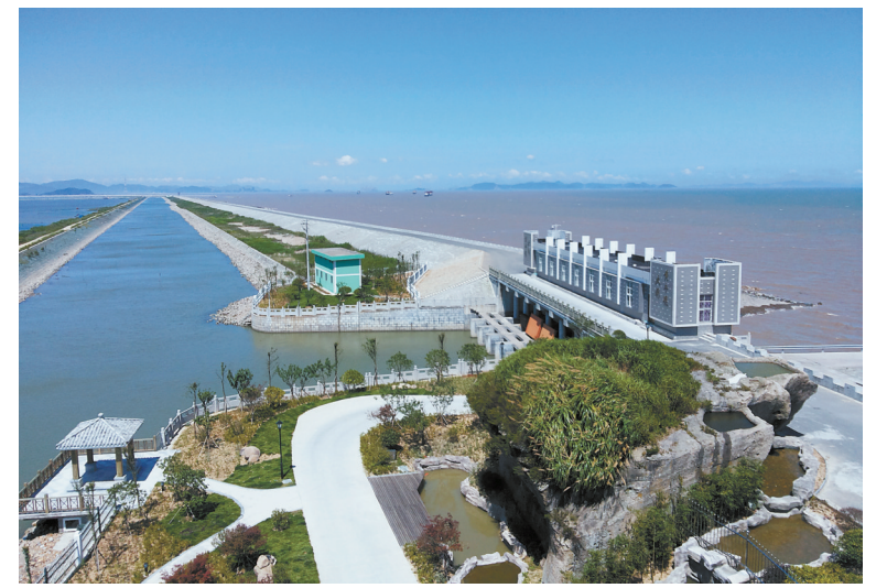
“保险+服务”，让宁波堤防(海塘)运行更安全。（市水利局供图）
