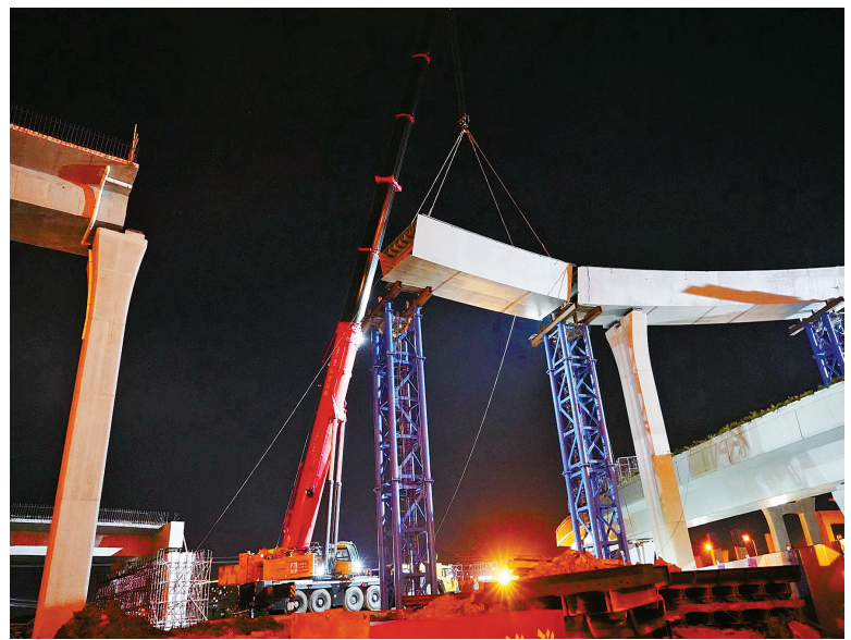
图为北环互通区钢箱梁吊装现场。(张奇 杨绪忠 摄)
