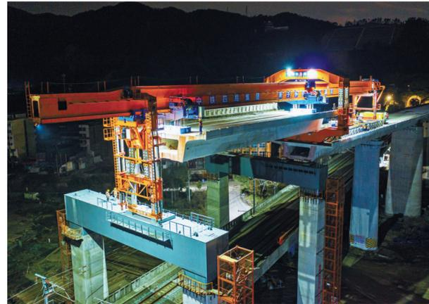
11月27日凌晨,中铁四局的工人在杭绍台铁路温岭跨甬台温铁路特大桥架梁现场进行“落梁”作业(无人拍照)。
