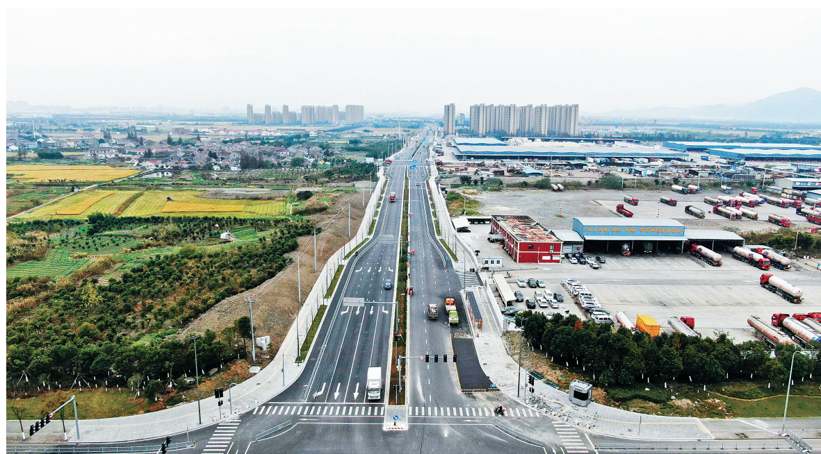
刚刚竣工的铸锋路。
