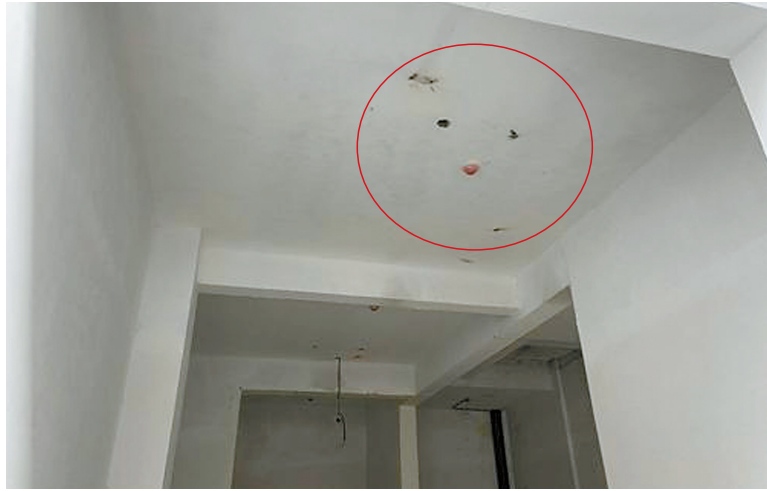
未装修的地下室天花板上的消防管道被拆除。(易民 摄)
