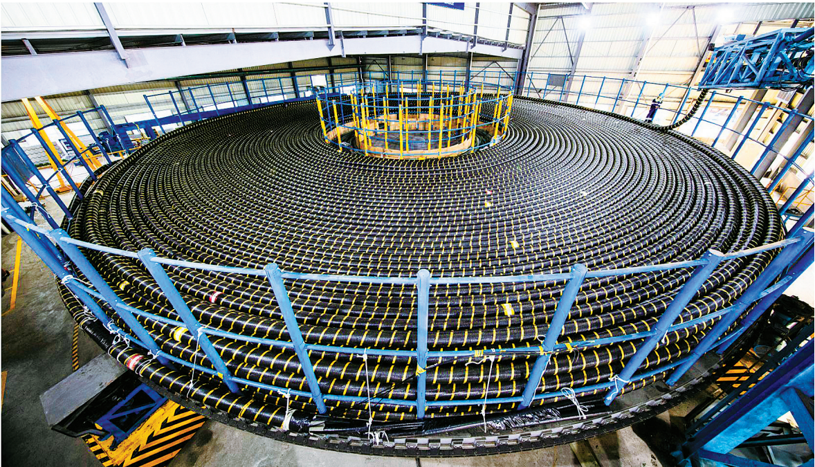
东方电缆生产线。(企业供图)
