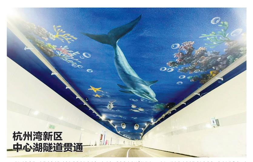
历经两年建设,坐落于宁波杭州湾新区前湾新城的中心湖隧道日前完成路面沥青摊铺施工,至此,该湖底隧道结构层全部完成,实现全线贯通。隧 道按双向四车道分离式设计,全长1105米,基坑最深为18.1米,是宁波以北近海漫滩地区已建和在建基坑深度之最。值得一提的是,中心湖隧道兼具 实用性与观赏性,摒弃传统黑色防火板,隧道顶部采用海洋世界主题。抬眼望去,鲨鱼、海豚、海龟、水母、海星等海洋生物的彩绘映入眼帘,让原本 (虐昌胜 黄程 摄) 枯燥乏味的隧道环境变得生动有趣,令驾驶者眼前一亮。
