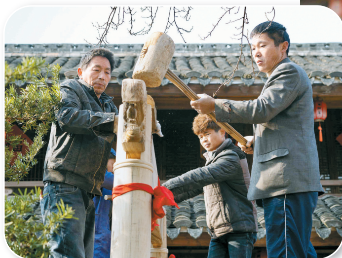
▲搭建过程中全部采用中国古建筑中最传统的榫卯结构。
