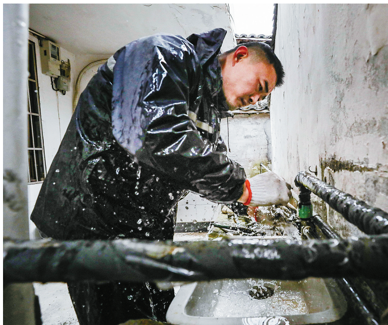
维修人员在抢修爆裂的水管。
