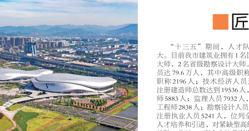
宁波奥体中心项目全貌
