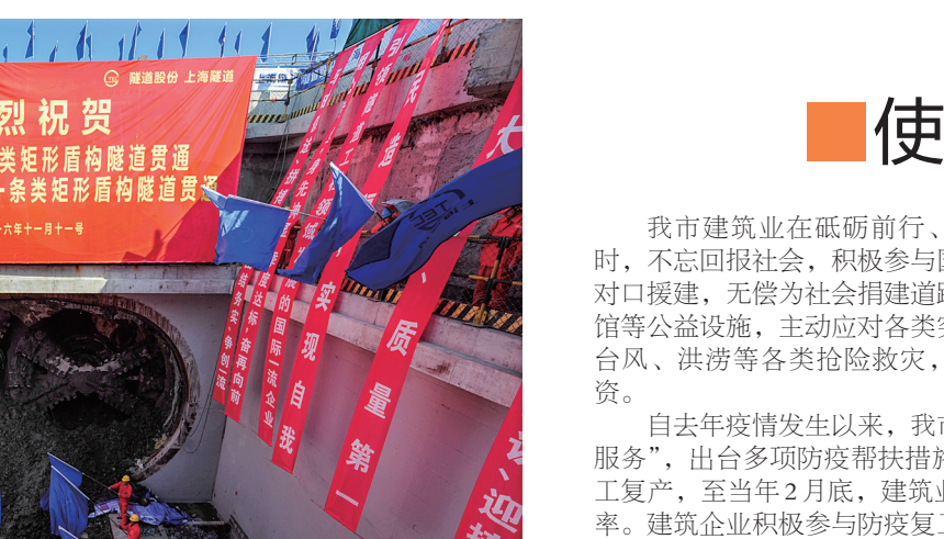
“阳明号”类矩形盾构机在宁波轨道交通3号线一期出入段线贯通
