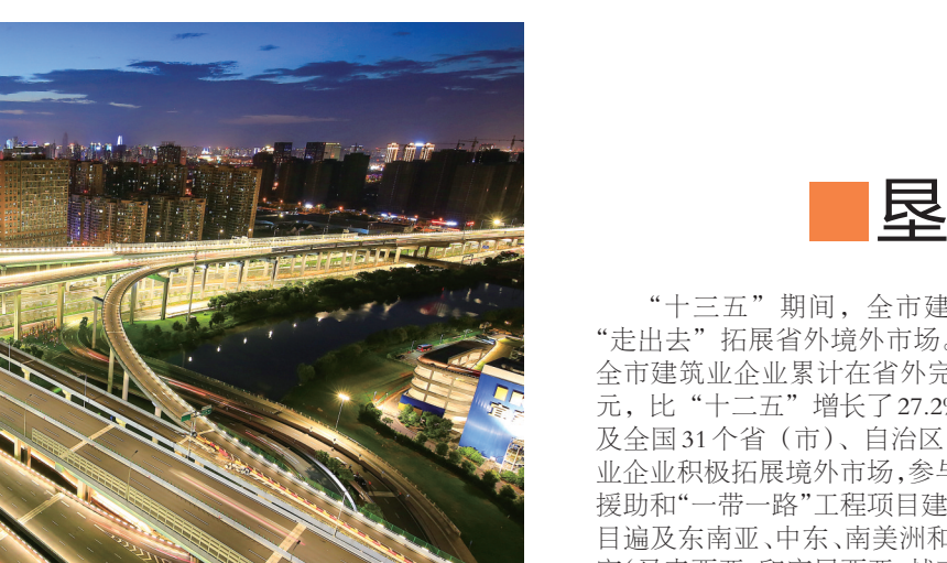
东苑立交快速化改造一期1标段
