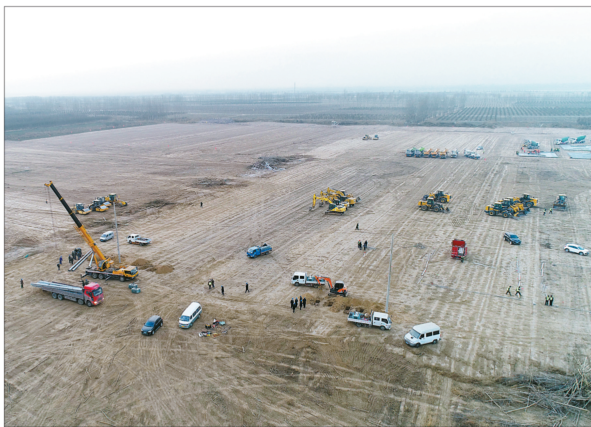
这是1月14日拍摄的石家庄市集中隔离点建设施工现场(无人机照片)。
