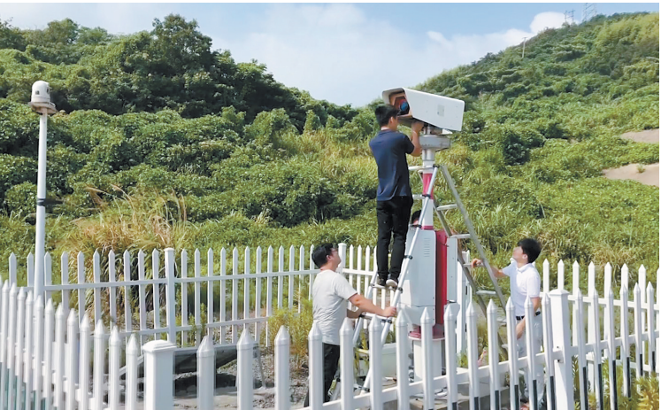
气象装备保障技术人员正在安装毫米波雷达。(资料图片 傅华英 摄)
