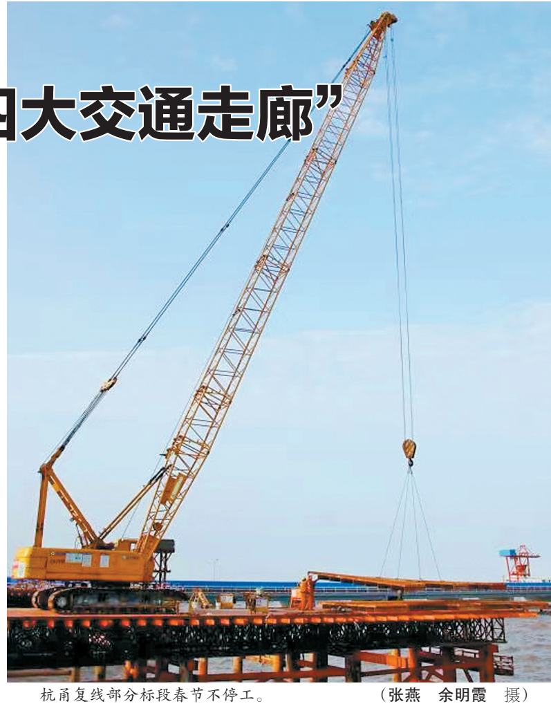
杭甬复线部分标段春节不停工。(张燕 余明霞 摄)
