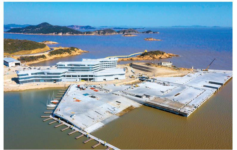
施工中的象山亚帆中心。(象山县委宣传部供图)
