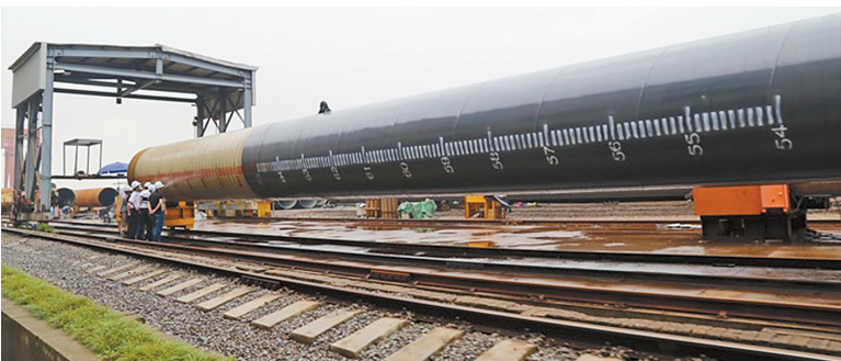
新一代海洋重防腐材料应用于舟岱大桥钢管桩上。（高晓静 摄）
