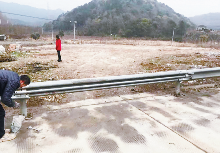
工作人员正在修复路边护栏。(仇龙杰 摄)
