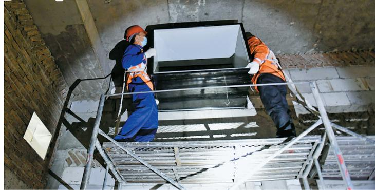
2月15日,中铁四局工人在杭州地铁9号线一期工程车站内进行设备房风管安装作业。春节期间,在浙江省重点工程建设现场,就地过年的工人们坚守岗位,加紧施工不停歇。(新华社发)
