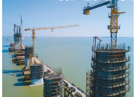
2月15日,施工人员在福建福厦铁路湄洲湾跨海大桥318#墩配合浇筑混凝土(无人机照片)。春节期间,来自中铁十一局的500多位建设者坚守施工一线,在距海面70多米的高空中进行各项作业。(新华社发)
