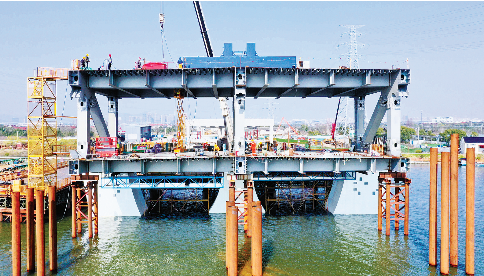
西洪大桥施工现场。（王鹏 王涛 摄）
