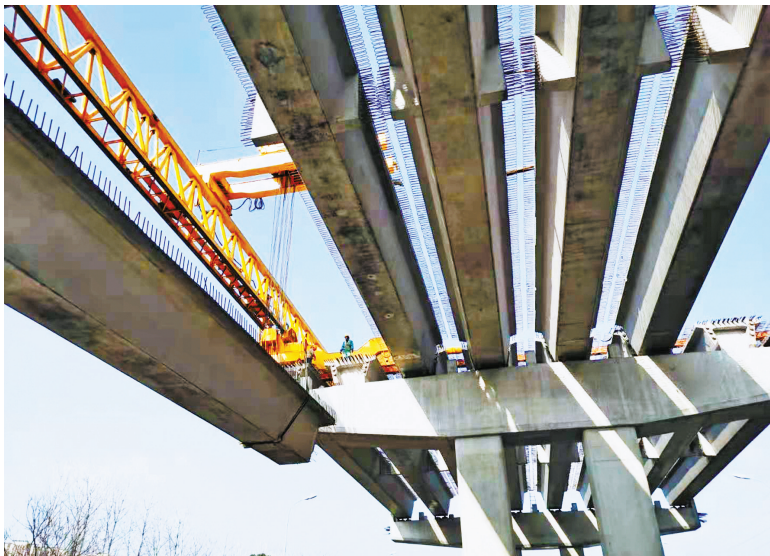
鄞州大道—福庆路快速路施工场景。
