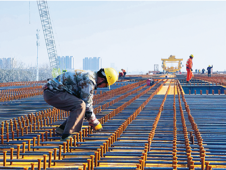
世纪大道快速路项目施工场景。
