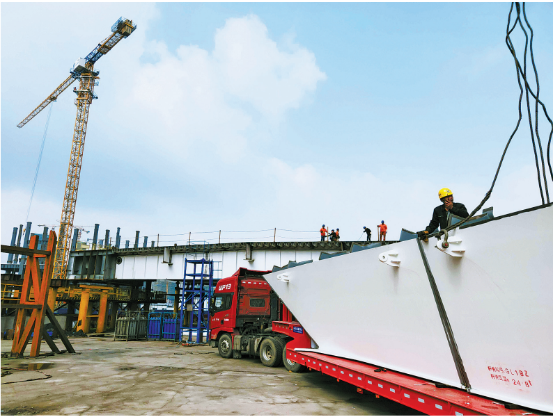
新典桥施工现场。
