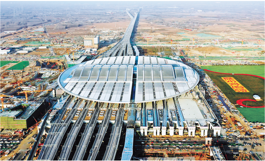
图为去年十二月二十三日拍摄的京雄城际铁路雄安站（无人机照片）。
