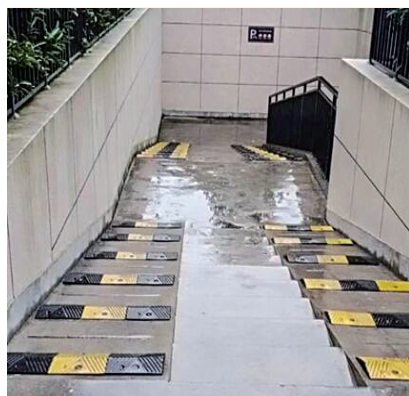
坡道改造前后
