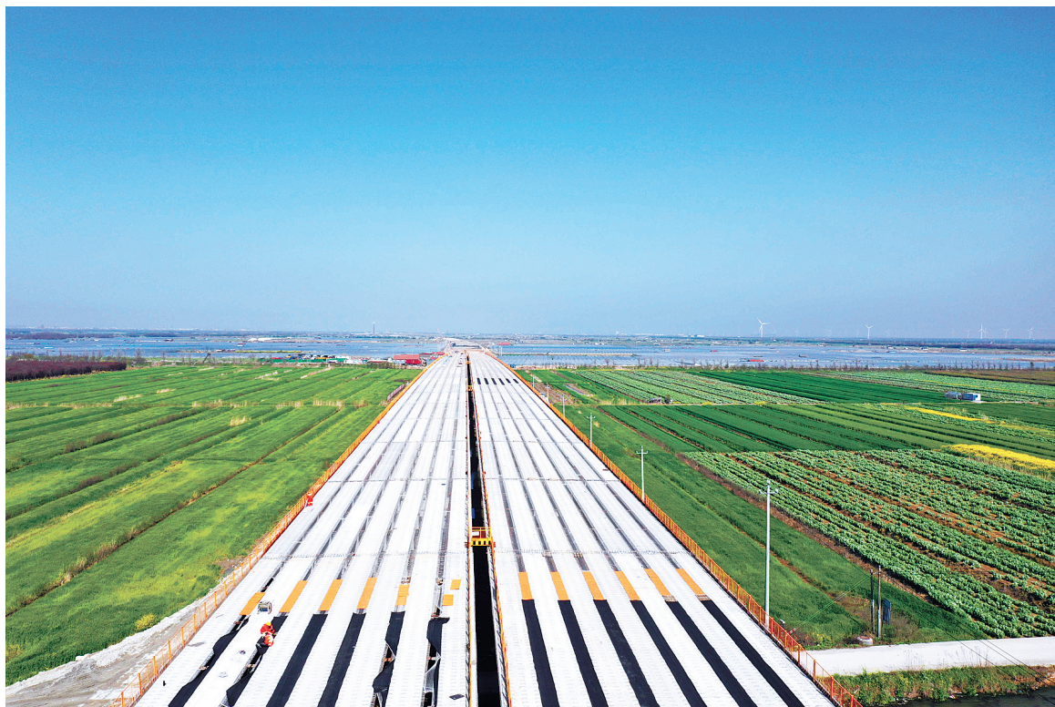
杭甬高速复线宁波段一期工程高背浦大桥梁板安装完成。
