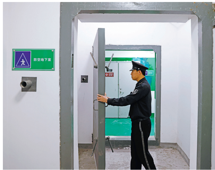
图为宁波传媒大厦，保安正在巡查地下防空设施。（王鹏 摄）
