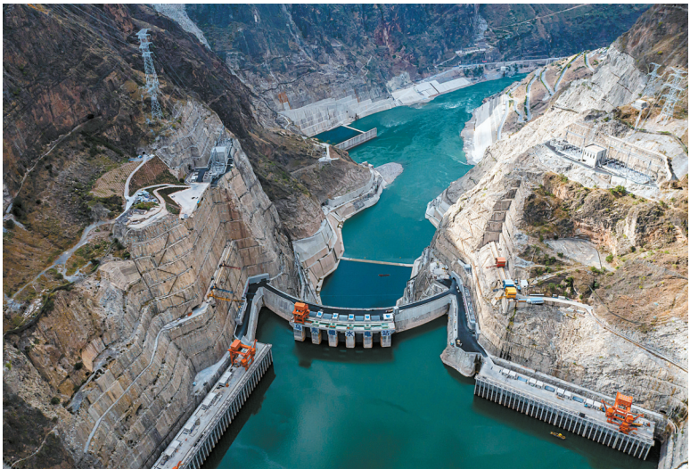
空中俯瞰乌东德水电站全景（6月16日摄，无人机照片）。
