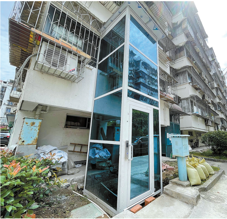
新安装的升降梯。（陈朝霞 励彤 摄）
