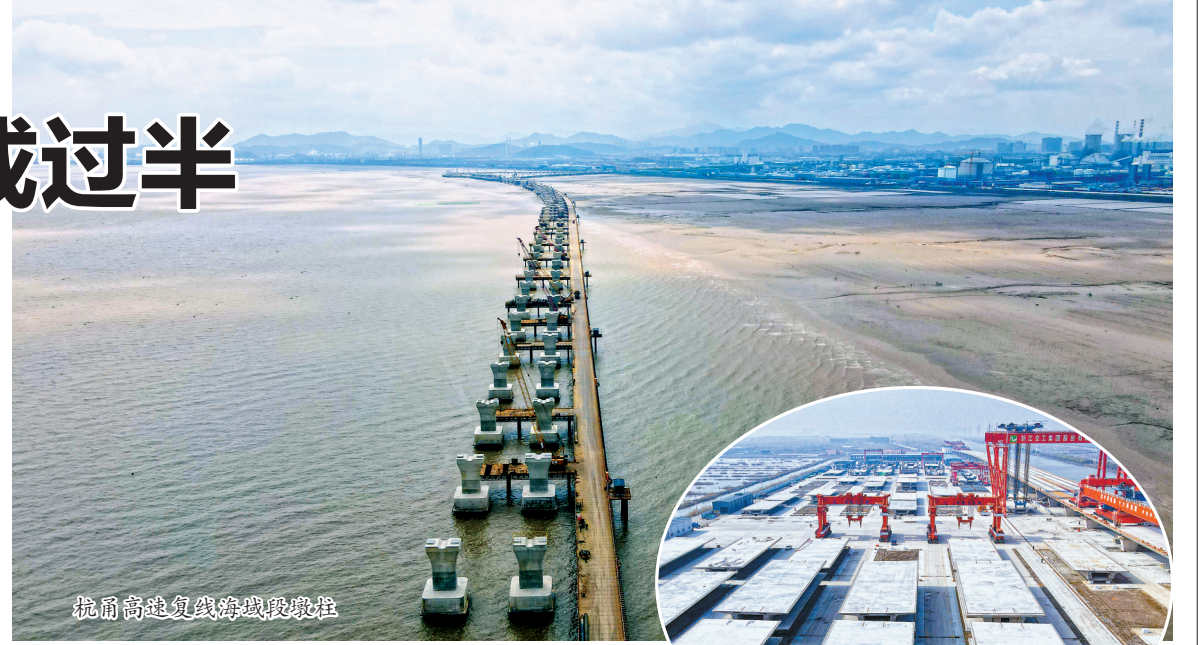
杭甬高速复线海域段墩柱 建设年”等活动，针对安全通道、临时用电、特种设备等开展安全检查62次，排查隐患227条，整改率100%。 据介绍，杭甬高速复线宁波段一期工程是市第一个高速公路PPP试点项目，项目位于宁波市余姚市、杭州湾新区、慈溪市和镇海区等区段，按120km/h的双向六车道高速公路标准进行设计建设，新建路线全长55.475公里，建设工期4年，预计2023年建成通车。 (张燕 张梅 陈姝玮 文/摄)
