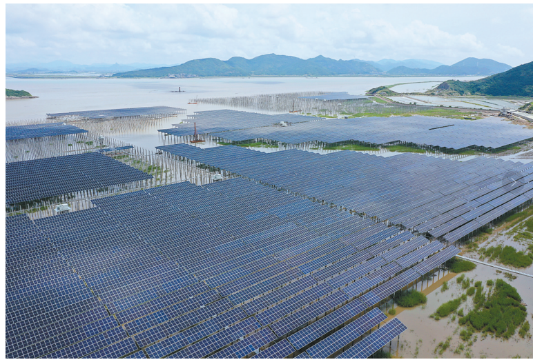
图为光伏项目施工现场。(董玉燕 摄)
