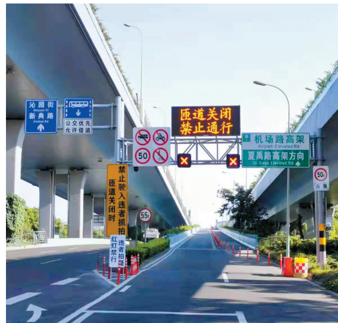
当显示屏显示“匝道关闭 禁止通行”字样时，车辆再从这上高架就要被罚款。（宁波交警提供）
