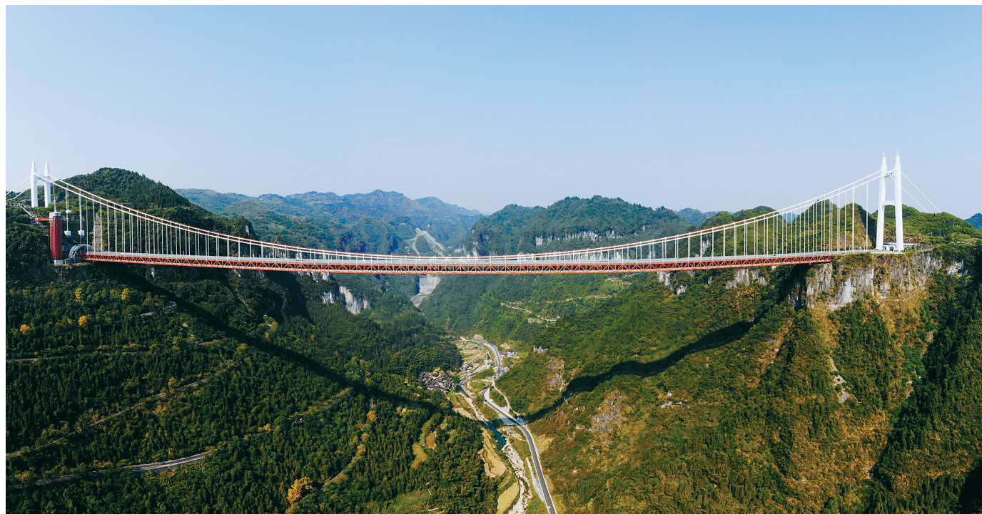
湖南湘西矮寨特大悬索桥。
