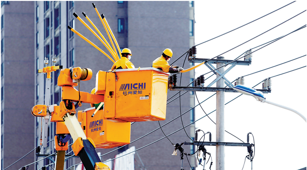
电力工人高温中开展10千伏线路不停电作业。（王幕宾 摄）
