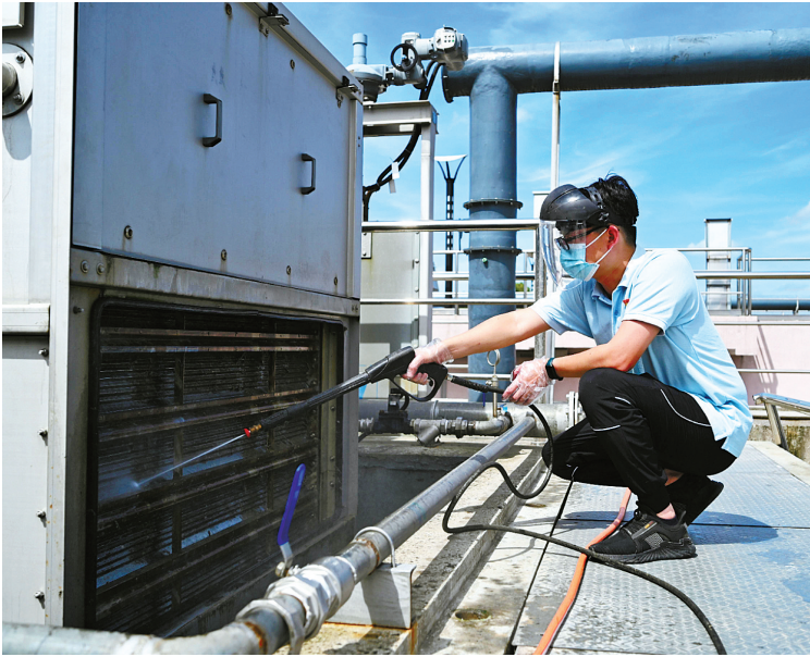
周科帆用高压水枪清洗格栅板。（王博 周欣怡 摄）
