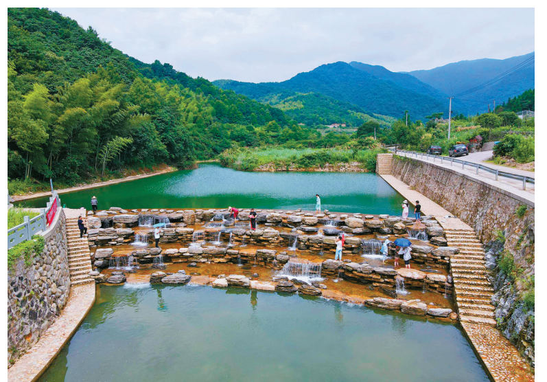
这几天，宁海县跃龙街道云台村的亲水平台吸引了不少游客前来游玩。该平台曾是废弃的小型水库发电站，后经整治改造，成了新晋网红打卡地。(徐铭 严龙 摄)
