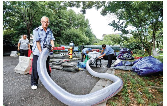
鄞州区东柳街道中兴社区地势相对低洼，很容易引起河水倒灌。昨天，该社区工作人员与物业管理人早早将8台潜水泵安排在大门附近及地下车库入口处，将社区和地下车库排水沟里的落叶、淤泥清理干净，并在车库显著位置张贴温馨提示。社区还在车库入口处整齐地堆放沙袋，每个角落都挡得严实，并加紧了蓝色防雨布。各片区网格员对社区进行排摸，消除高空坠物、疏散通道杂物拥堵等隐患。图为社区工作人员与物业管理人在摆放潜水泵。（刘珏 严龙 摄）
