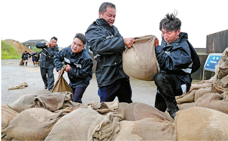
昨天，在宁海县长街镇伍山轮渡码头，长街镇综合执法中队队员正在用沙包加高加固渡口低洼处。台风“烟花”逼近，该中队数十名队员用了5000多个沙包，将渡口低洼处加高近2米，以防海水倒灌。
