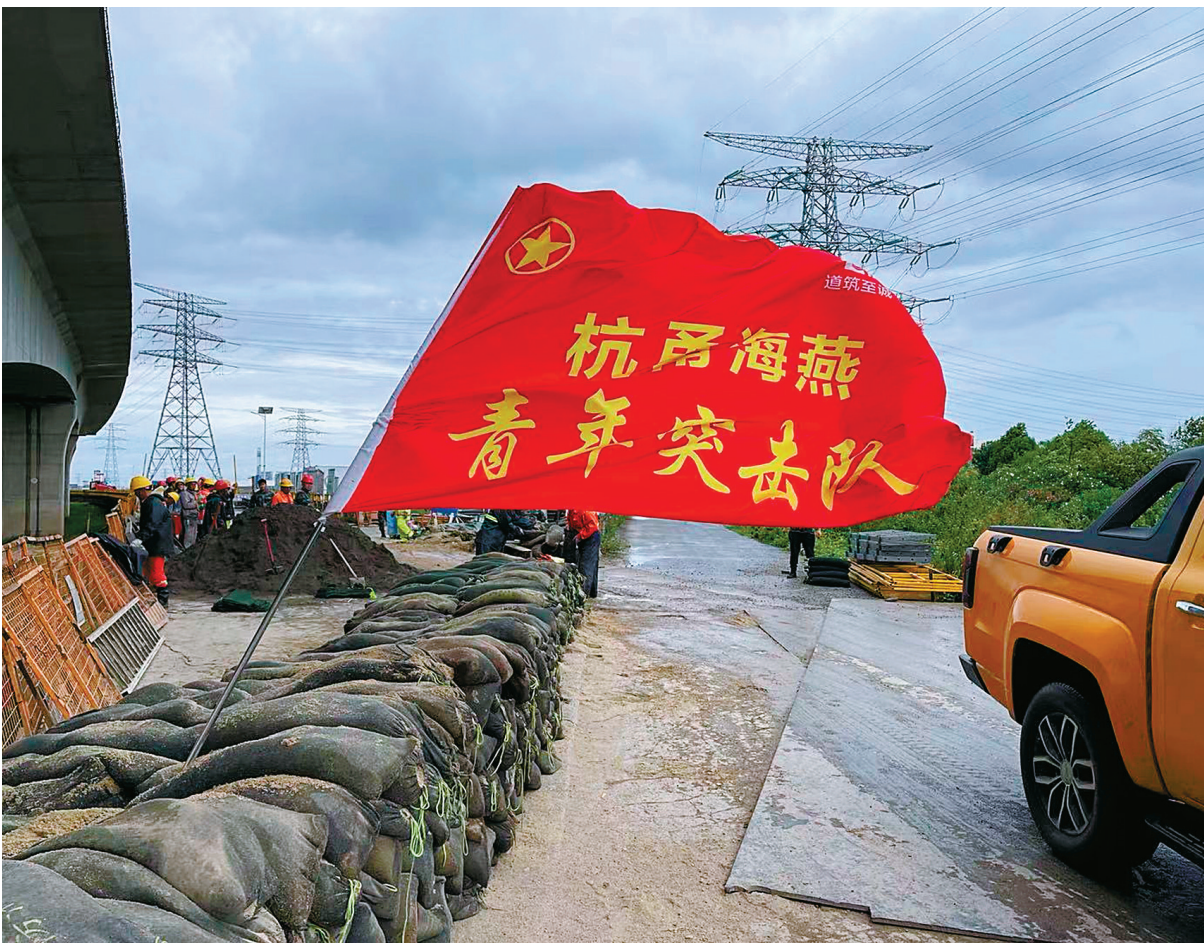
杭甬高速复线宁波段一期项目部加固镇海石化区海堤。
