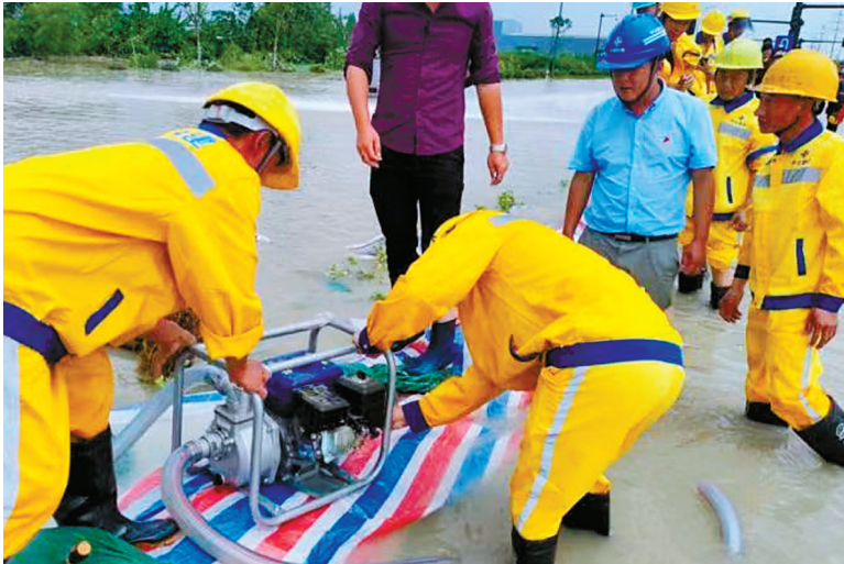
宁波象山湾疏港高速TJ-1标项目部在余姚抗洪救灾。
