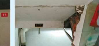
▶联丰菜市场内通往地下室楼道中的杂物已被全部清理。
