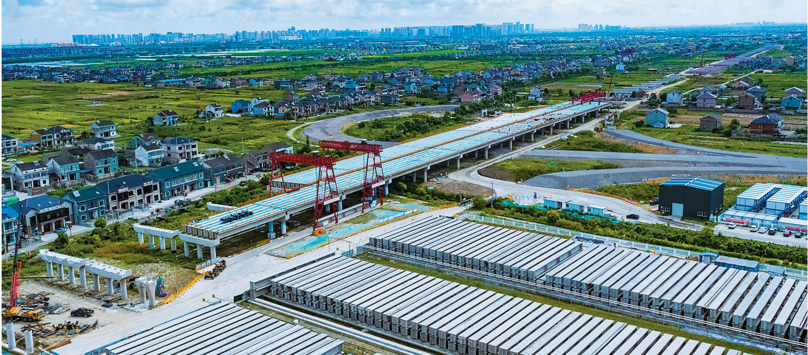
杭甬高速复线宁波段一期工程西段增投入、促生产、严防疫，快速推进工程进度，西段工程开辟双谭大桥、大陈家路大桥、小曹城枢纽、庵东西互通、三八大桥、主线路基段等9个工作面，累计完成墩柱1320根、预制T梁1215片、盖梁154片，工程进度实现48%，顺利实现既定建设目标。
