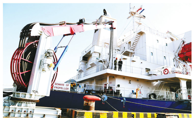
宁波舟山港投资的太仓万方为船舶提供岸电。(陆洲 摄)
