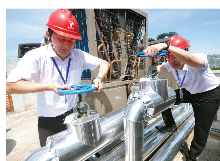
工作人员在演示跨临界CO2空气源热泵冷暖系统。(陈结生 摄)
