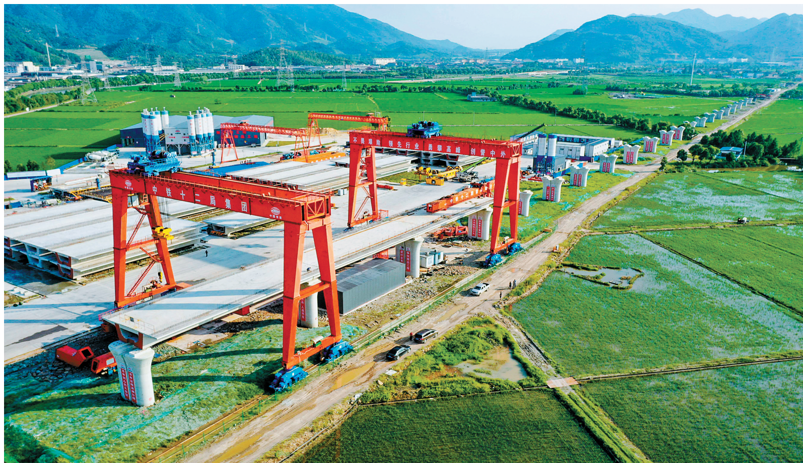
吊臂起落、机器轰鸣,作业人员忙着绑扎钢筋、浇筑混凝土、安装挂篮设备……连日来,横跨奉化区、鄞州区的金甬铁路【标段施工现场热火朝天。该项目段全长约16公里,自2020年4月主体工程动工以来,陆续完成了首座隧道贯通、连续梁浇筑等多项施工节点,已完成总工程量的45%。目前项目施工全面提速,计划于2022年完成主体工程,2023年初开始铺轨。图为施工现场。(严龙 郑连乔 摄)
