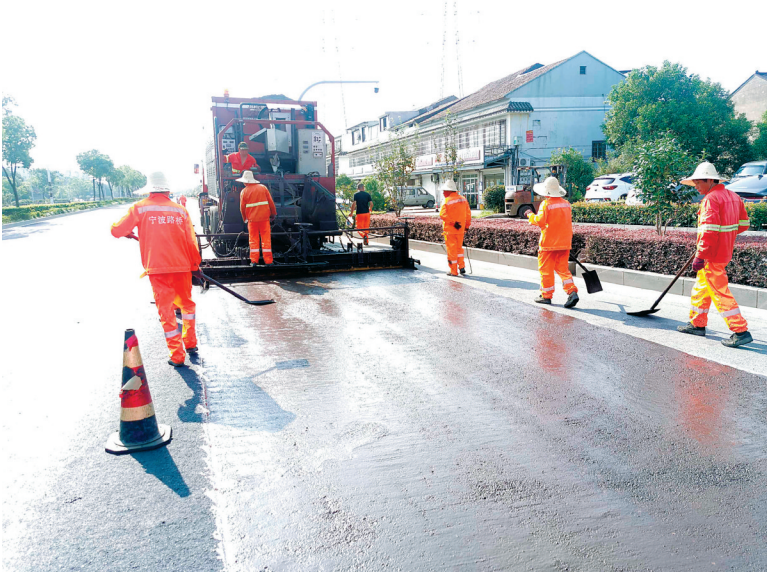
骆霞线施工现场。
