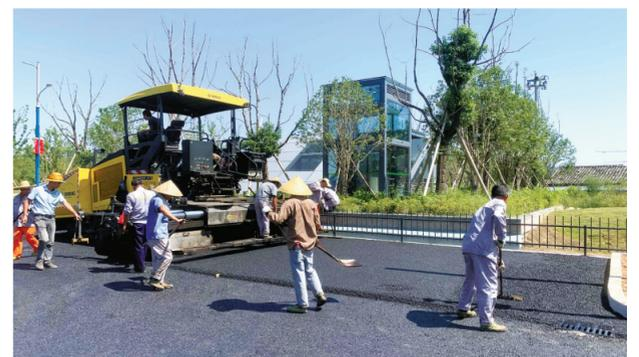
前天,记者来到轨道交通4号线小洋江站P+R停车场建设工程现场,看到整个工程建设已进入扫尾阶段,工作人员正在进行沥青上层及其他附属工程的施工,有望国庆前正式投用。据了解,小洋江站P+R停车场建设工程6月初开建,总占地面积3000平方米,共设置停车位106个。(朱军备 白洪辉 摄)
