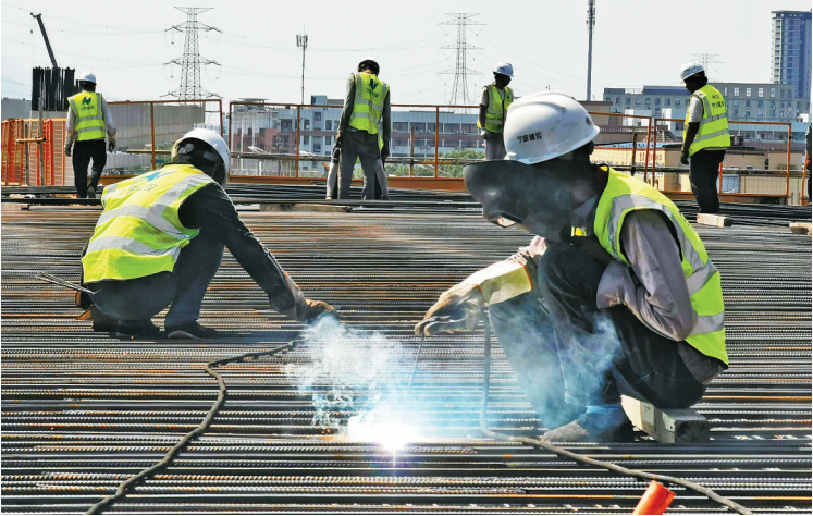
工人正在焊接。(徐卓蔚 张彩娜 摄)
