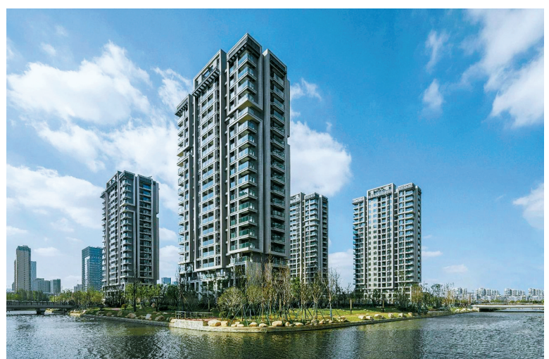
滨水建筑空间。
