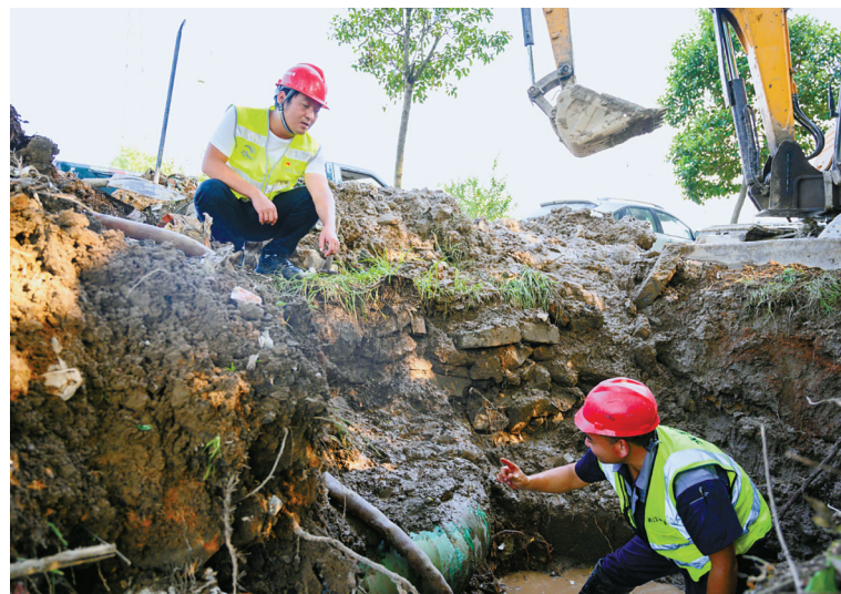
唐建立(上)在供水管道抢修现场。
