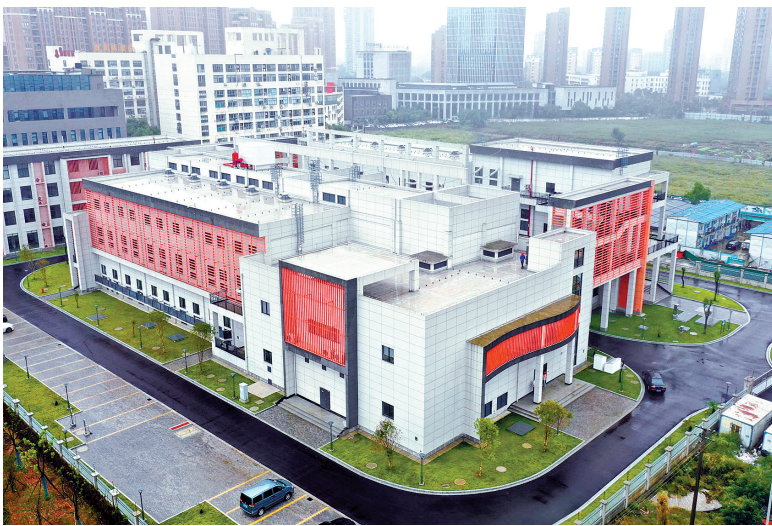
新投运的220千伏潘桥变。
