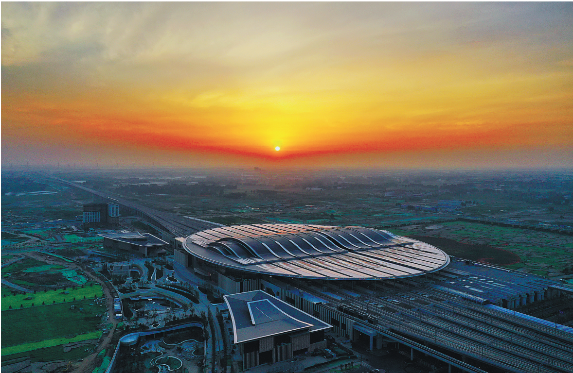
这是7月1日拍摄的京雄城际铁路雄安站（无人机照片）。（新华社记者 牟宇 摄）
