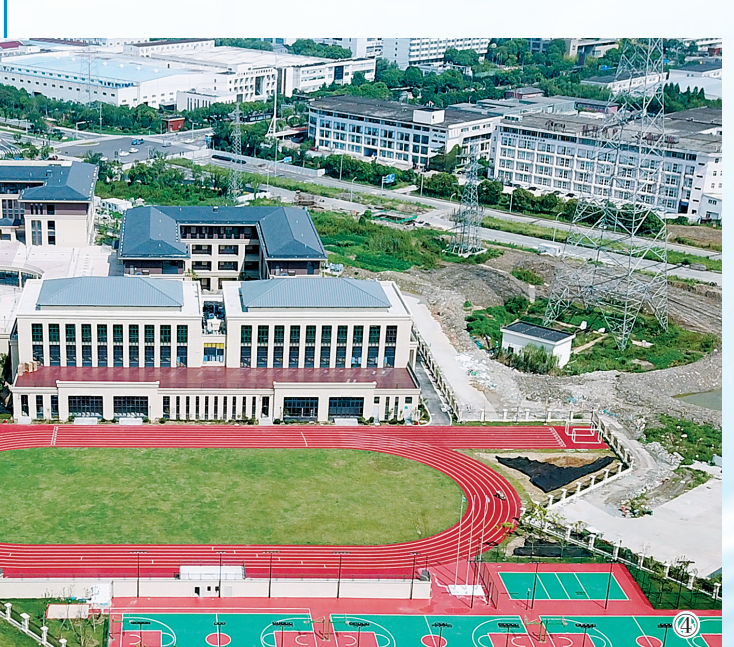
①宁波栎社国际机场三期扩建工程—T2航站楼 ②宁波大学医学院附属医院原地改扩建工程 ③宁波市城市建设档案馆迁建工程 ④江北工业区配套学校及绿地工程
