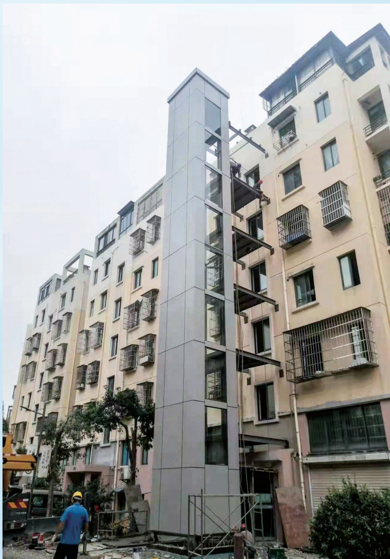
江北洪塘街道欣欣家园电梯安装
