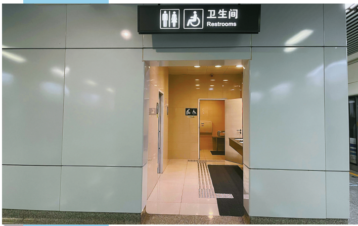
无障碍厕所入口设置了盲道指引。
