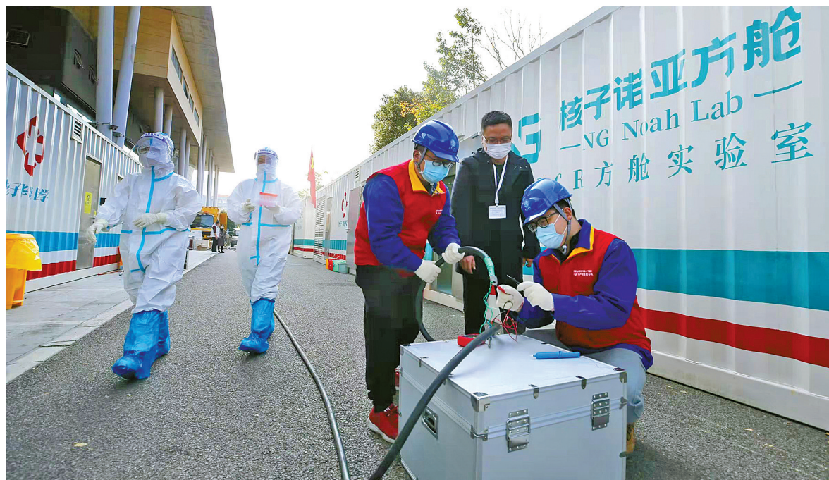
昨天上午,经过9个多小时的奋战,海曙文体中心检测点完成临时配电箱安装和应急发电车接入,海曙区3座大型移动式核酸检测方舱实验室通电投用。(王嘉宾 王鹏 摄)
